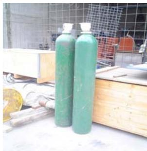
**Riesgo por uso de gases comprimidos.** Cilindros de oxígeno sin el debido soporte o mecanismo de sujeción para evitar caídas que den origen a lesiones o fugas.
