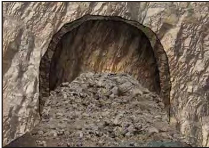
Figura 3.21 Buena voladura con mínimo daño a la periferia de la excavación.
