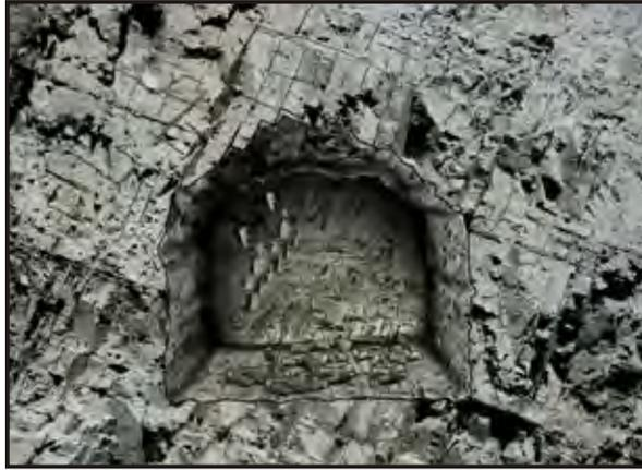
Figura 2.25 Agrandamiento de la sección de la excavación por inestabilidades de cuñas y bloques.
