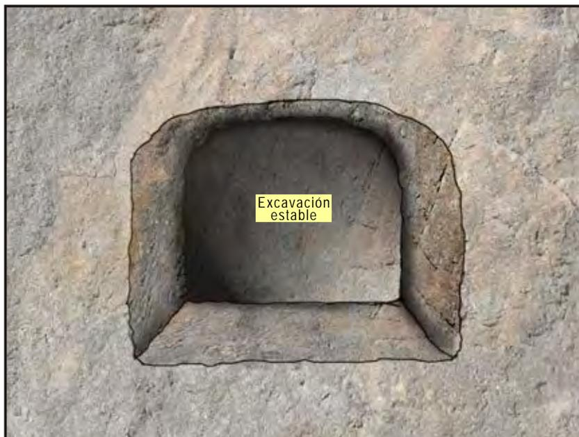
Figura 2.2 Ejemplo de roca masiva con pocas fracturas, que presenta condiciones favorables para la estabilidad de las excavaciones asociadas al minado.
