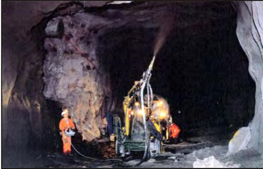
*Figura 4.32 Empleo de equipo robótico para shotcrete.*
