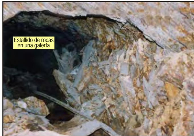
Figura 2.15 Roca masiva o levemente fracturada sometida a altos esfuerzos, en donde pueden ocurrir astillamientos, laminamientos, reventazones y hasta estallidos de rocas.
