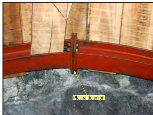
Figura 4.38 Accesorios de conexión.
