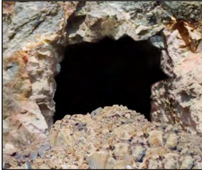
*Figura 2.50 Daños causados por voladura.*
