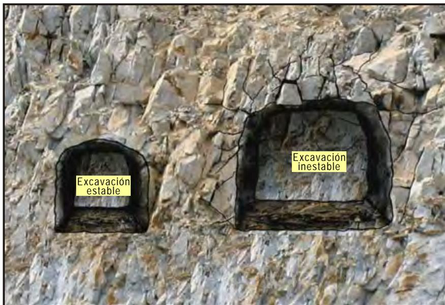
Figura 2.27 Cuando las dimensiones de la excavación crecen, aumenta la posibilidad de que la roca pueda deslizarse o caerse.
