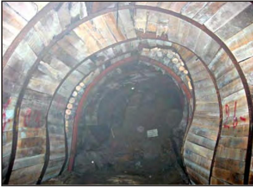
Figura 2.20 Daños al sostenimiento por presiones de rocas expansivas.
