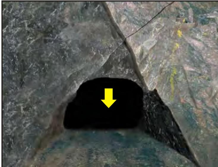
Figura 2.3 Cuñas biplanares liberadas por las intersecciones de diaclasas en rocas fracturadas, las cuales pueden caer o deslizarse debido a las cargas gravitacionales.
