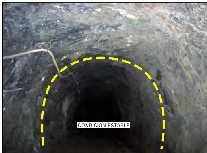
Figura 3.10 La forma en arco de las excavaciones favorece la estabilidad.
