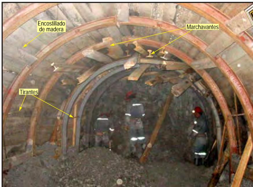
Figura 4.39 Instalación de cimbras utilizando marchavantes.
