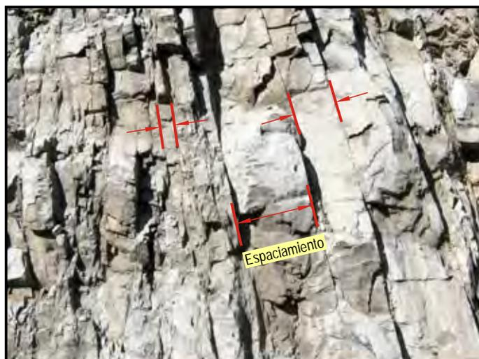
Figura 1.15 Espaciado de una discontinuidad.
