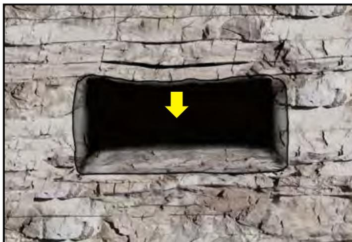
Figura 2.8 Separación o despegue de los estratos subhorizontales, flexión y caída hacia el vacío minado.
