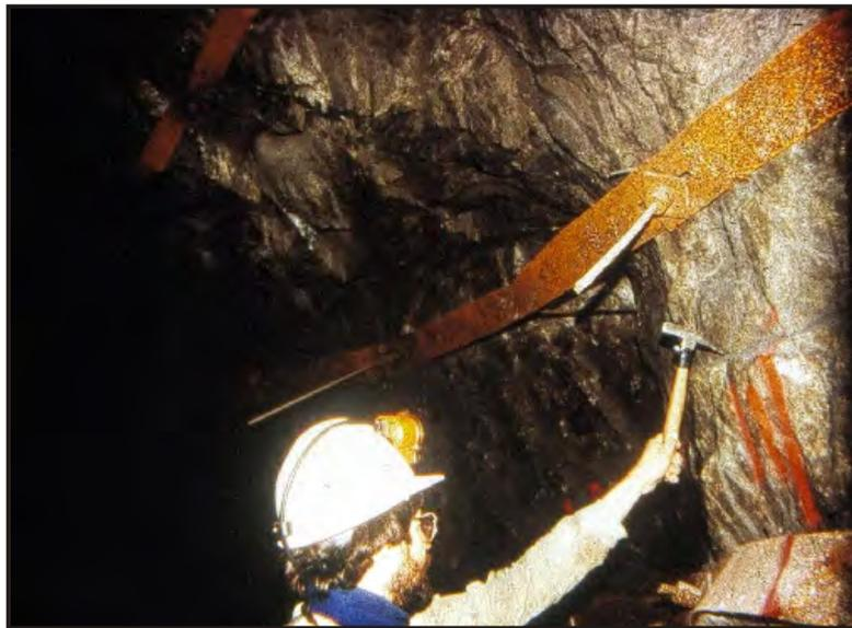
Figura 4.25 Reforzamiento con cintas de acero.
