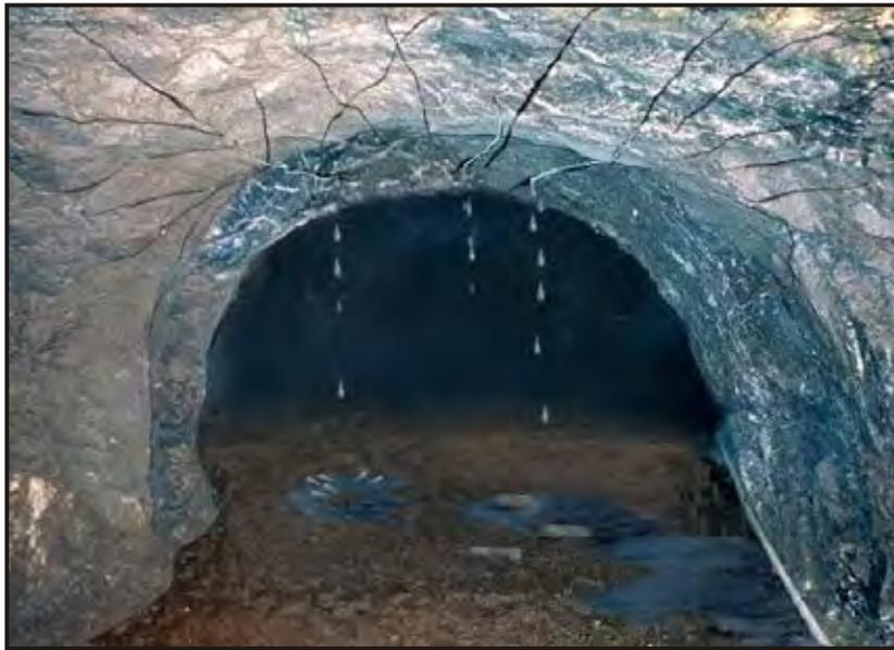
*Figura 2.21 El agua puede lubricar las familias de discontinuidades y permitir que las piezas de rocas se muevan.*
